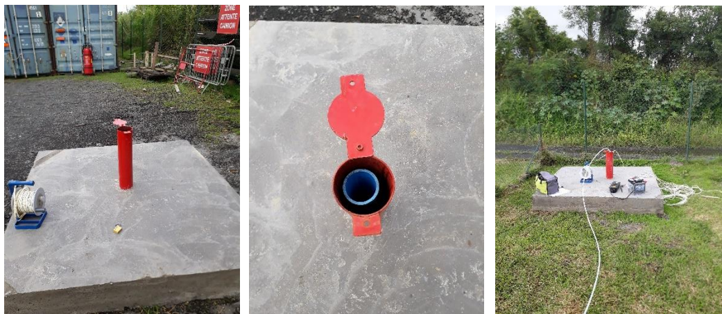
Figure 25 : Photographies des piézomètres installés
