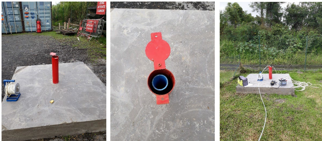
Figure 3 : Photographies des piézomètres installés
